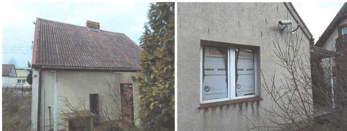
Stan techniczny budynku, w którym znajduje się pomieszczenie biurowe
